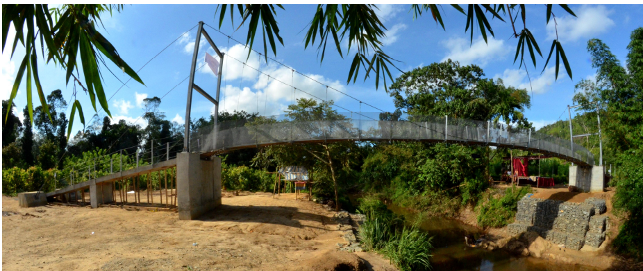
Brücke unmittelbar vor der Fertigstellung (Foto: EWB Karlsruhe)
